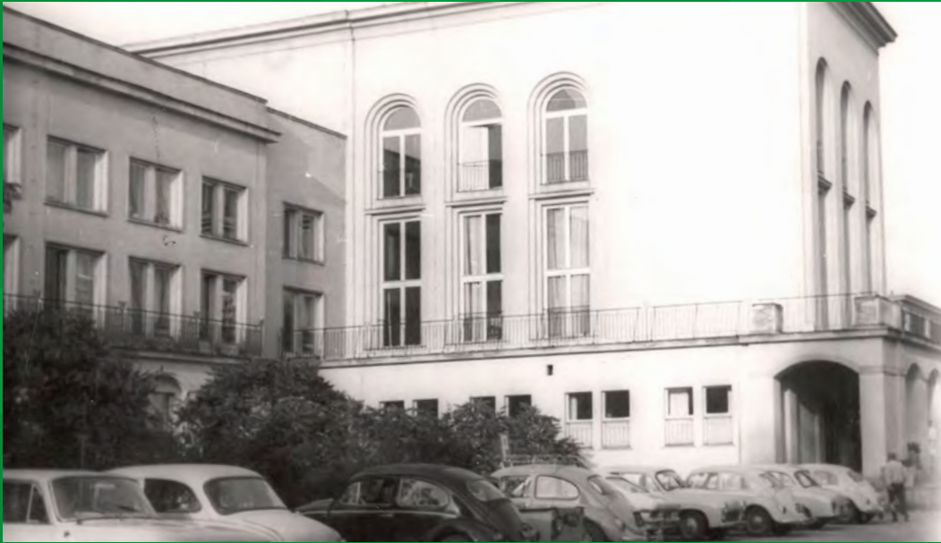
The building at 36 Rakowiecka Street in Warsaw, the headquarters of the Institute from 1963 to 1993 Gmach przy ul. Rakowieckiej 36 w Warszawie, siedziba Instytutu w latach 1963–1993
