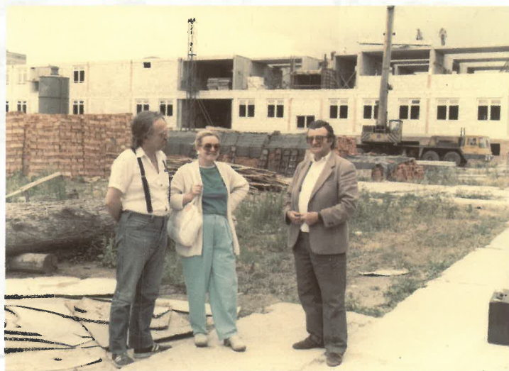
Początki budowy – Wojciech Bartnikowski, Irena Golczyk i Albin Gniewaszewski (kierownik budowy) na tle pierwszych kondygnacji gmachu, lato 1988.
